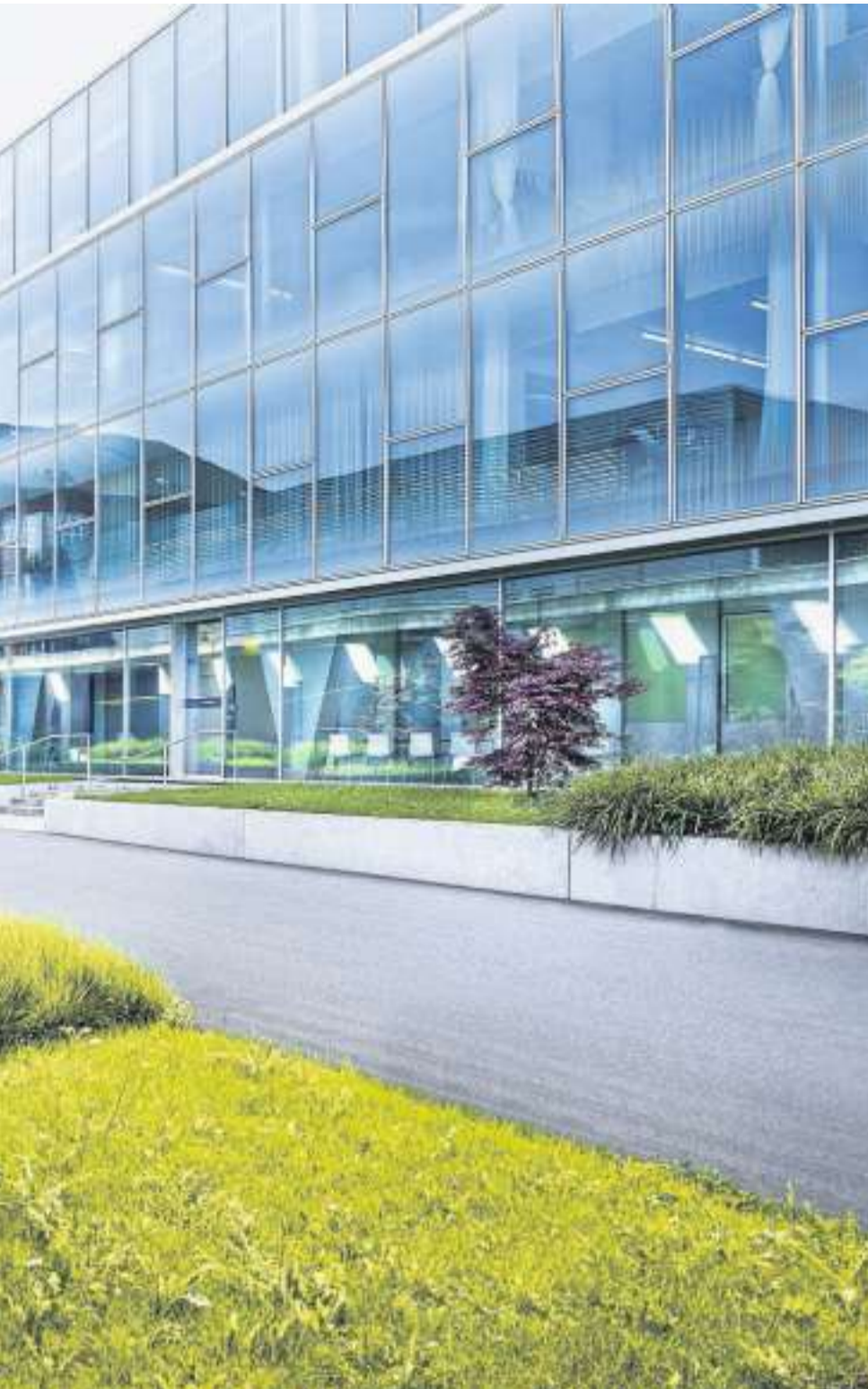
enzimmer auf Einerbelegung ausgerichtet.
